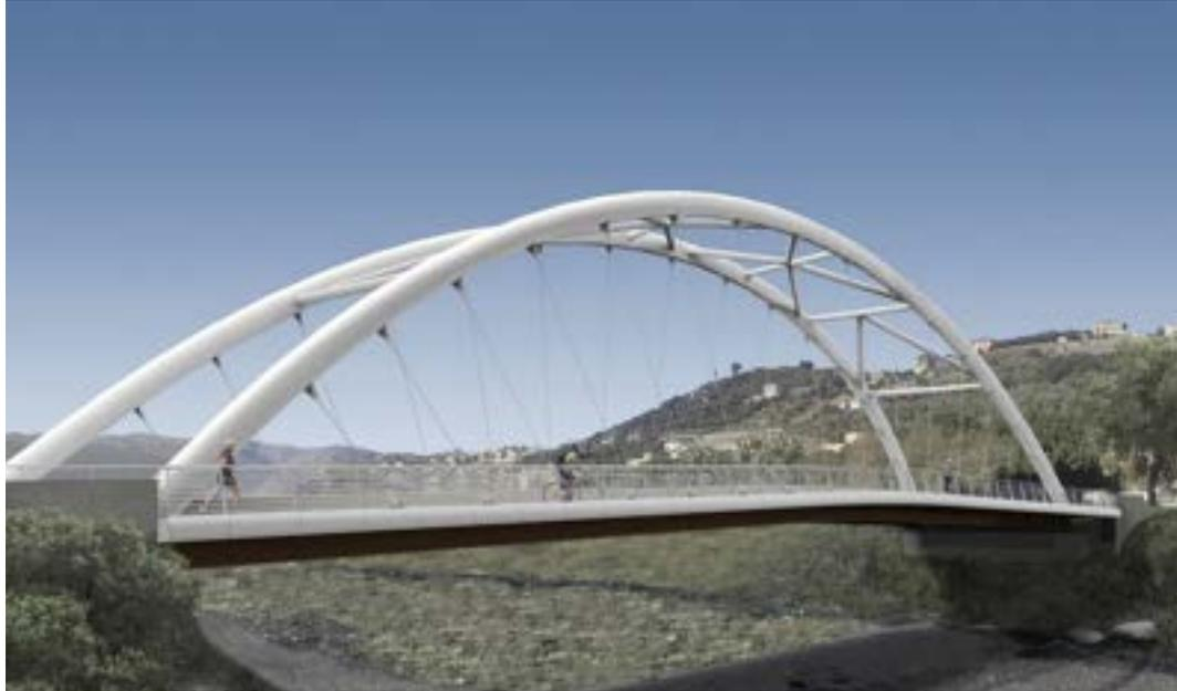
La nuova opera, che sostituirà - previa demolizione - il ponte esistente, sarà più ampio di quello attuale, con una larghezza carrabile pari a 7 metri, a cui si aggiungeranno ulteriori 4 metri, ripartiti sui due lati, dedicati ai corridoi ciclo-pedonali.
